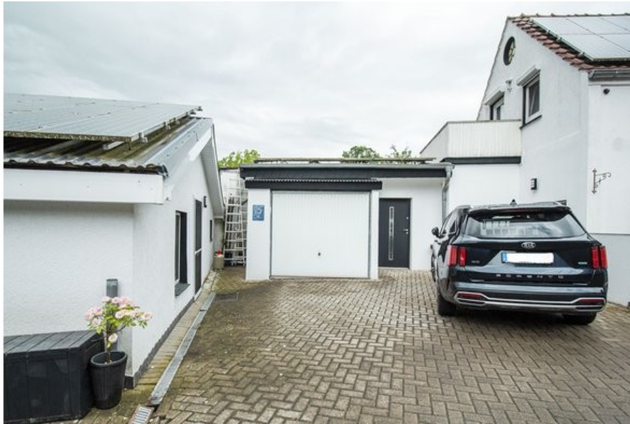
Garage - elek. Tor
